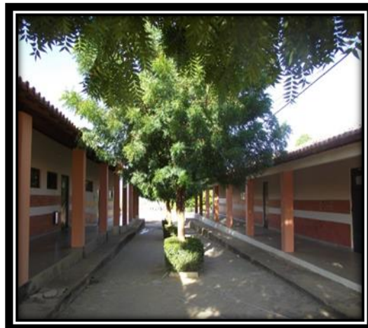
Fig. 02: Bloco de Salas de Aula
